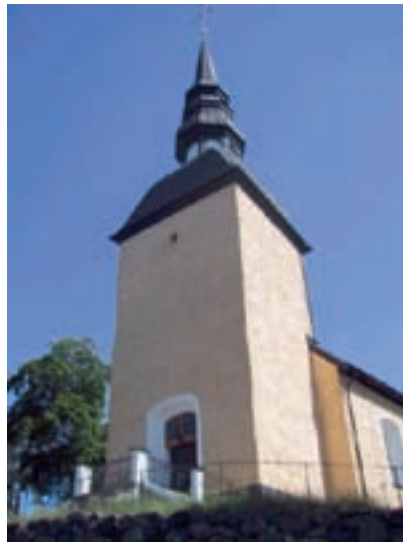
Björnlunda kyrka med det nuvarande tornet och tornspiran som byggdes 1660.
